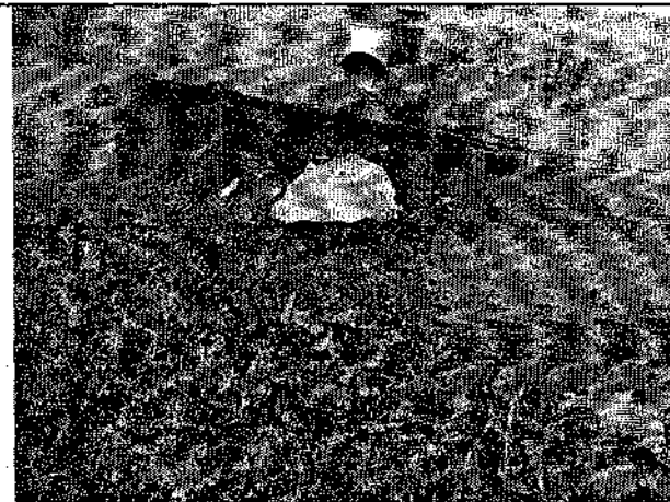
Фото 7, 8. 9. 10. Вымывание отделочного покрытия (цементной штукатурки) у цоколя, что не соответствует требованиям раздела 4 СП 71.13330.2011 «Изоляционные и отделочные покрытия».
